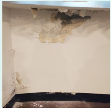
■ 公館分館壁癌處理及防護。
