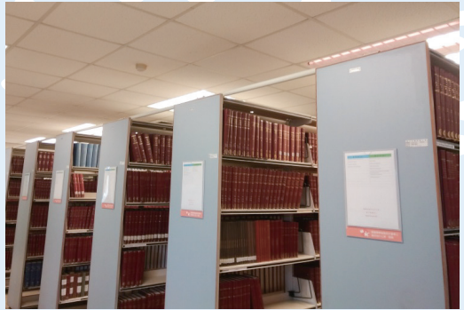
■ 公館分館裝設書架防震連桿。
